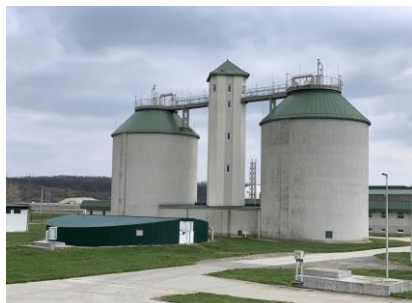
1-2. ábra: Fermentor tornyok, gázfáklya, gázsűrítő gépház, és a gáztároló (Készítette: Mészáros Imre)
