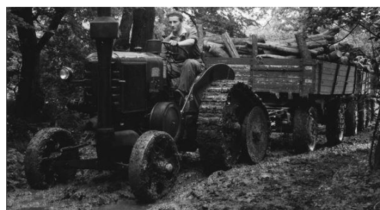
2. kép: Két pótkocsis szállítás Hofherr féllánctalpas traktorral (forrás: SoE ERTI fotóarchívuma)
