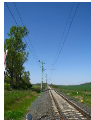
4. ábra. A felsővezeték-rendszer
